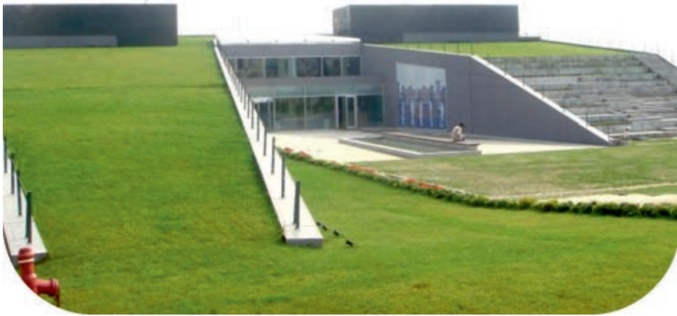
Şekil 2. Bir Yeşil Çatı Uygulaması Örneği- Turkcell ARGE Binası, Gebze, Kocaeli
